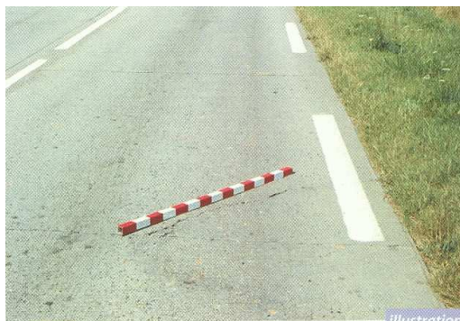
FIGURE 2.8. Fissure oblique de dalle [LCPC, 1998]
