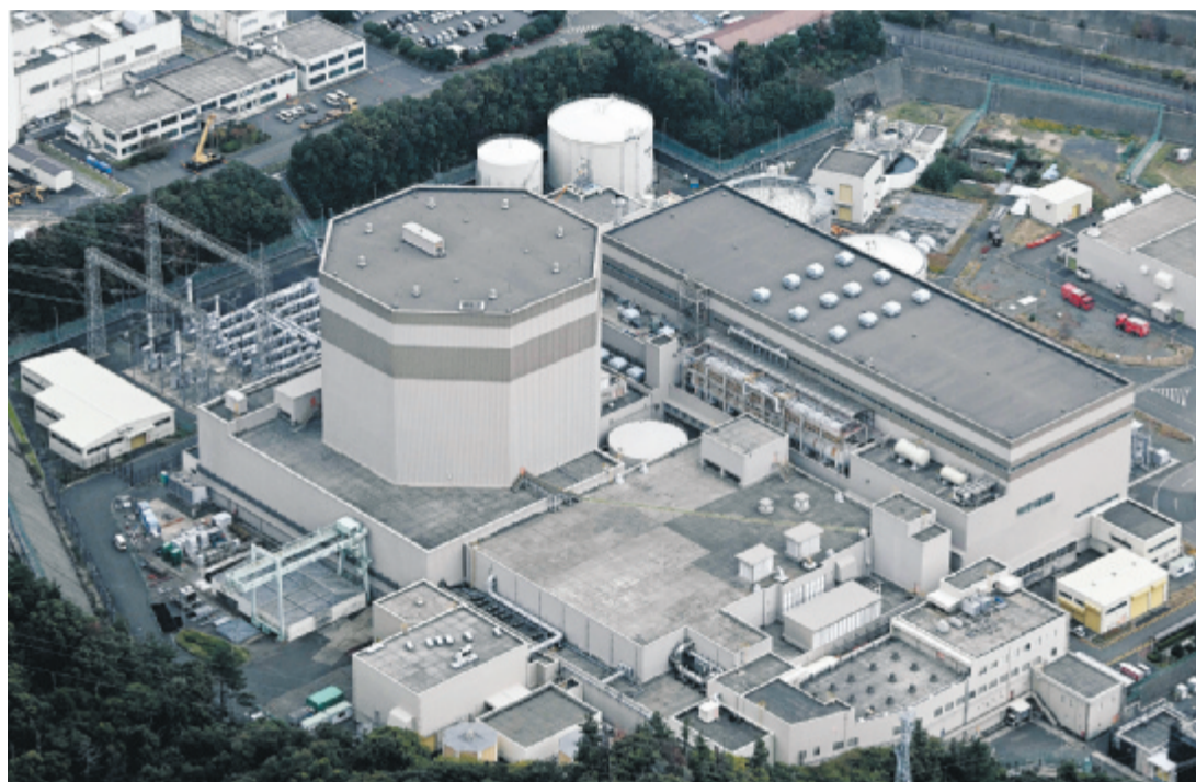
日本原子力発電敦賀原発2号機 2023年11月、福井県敦賀市で
